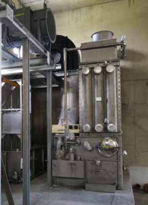
Wärmerückgewinnungsanlage während der Montage
