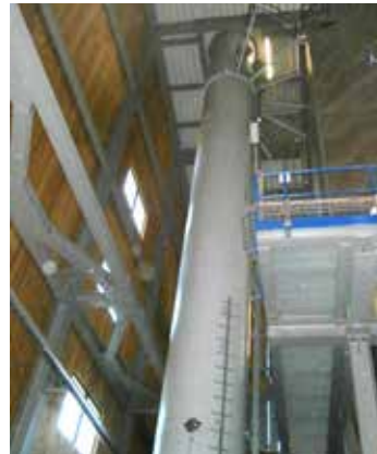
Aufstellungsort im Heizhaus VORHER
